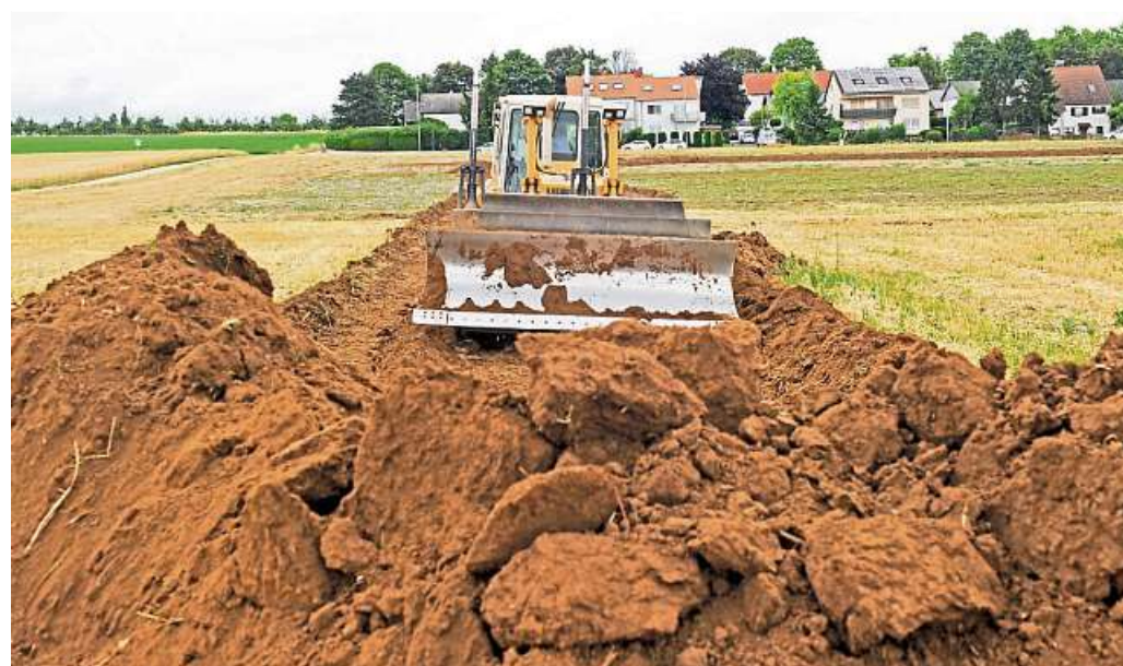
Im Sommer vergangenen Jahres waren die Bauarbeiten gestartet.
